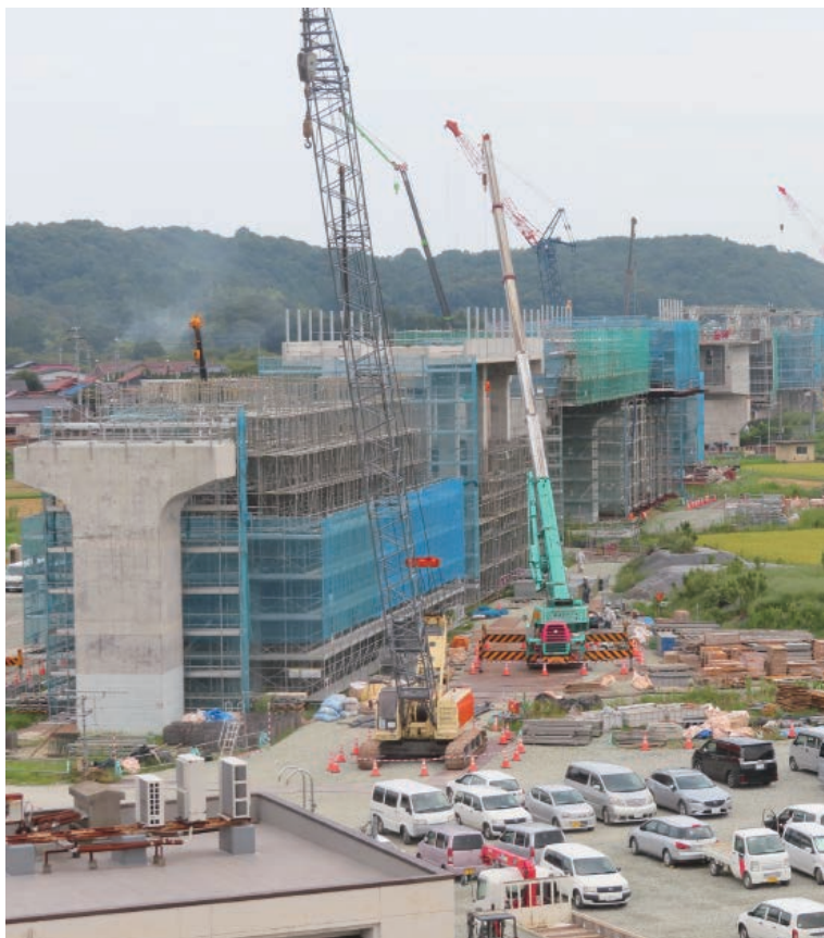
加賀市商工会議所屋上からの展望
