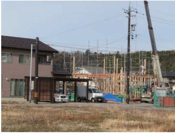
新築工事の進む大聖寺福の村
